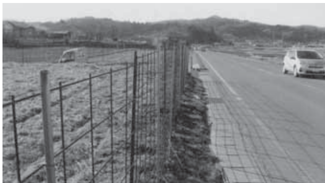
イノシン対策でワイヤーメッシュを設置（鶴沢地区）
