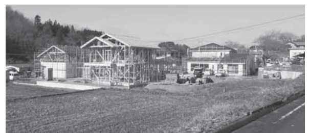
建築中の民間住宅団地
