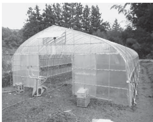
復旧したビニールハウス
