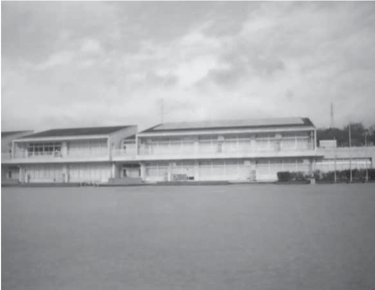
川俣町南小学校太陽光パネル
