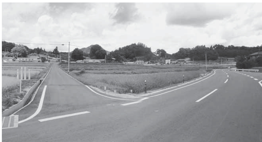
羽田工業団地造成予定地
