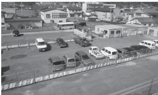
大幅に遅れている庁舎建設
