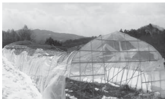
豪雪により倒壊したパイプハウス
