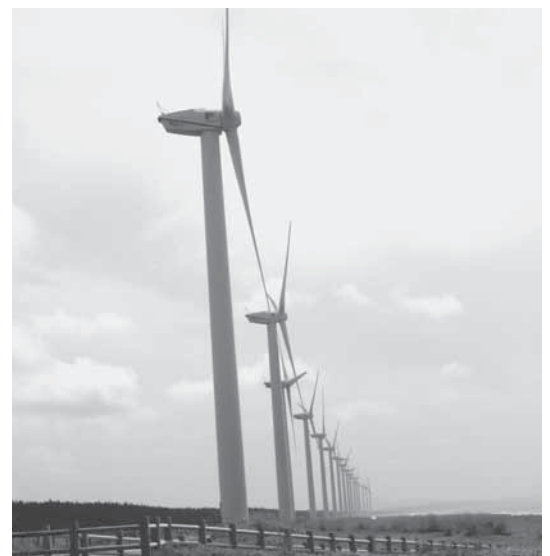
産業建設常任委員会で視察した八竜風力発電所 (秋田県三種町)
