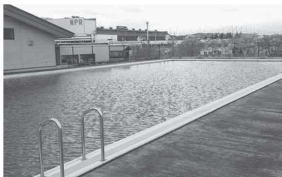
令和6年度に解体予定の旧飯坂小プール
