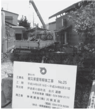
町が実施している被災家屋等解体工事現場
