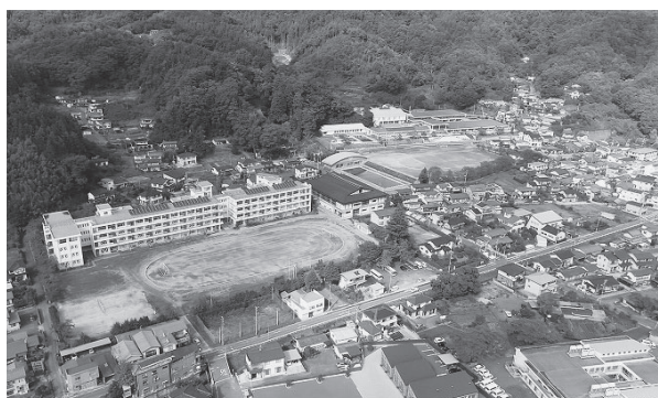
改修予定の川俣小学校（右奥）
