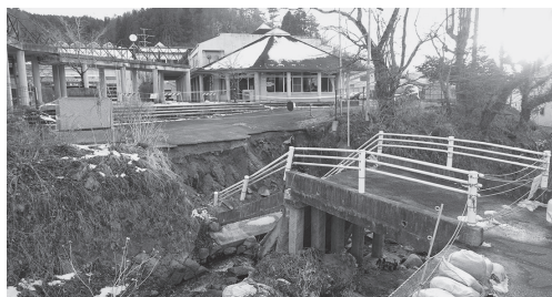
河川改修後、年度末に工事着工へ
