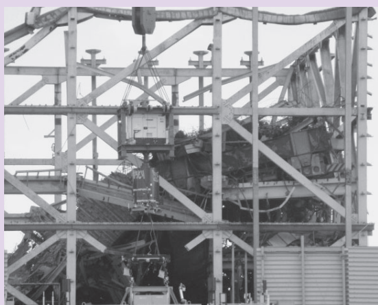
飛散防止カバーを掛け替え中の1号機
