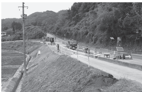
ようやく改修工事の始まった国道349号
