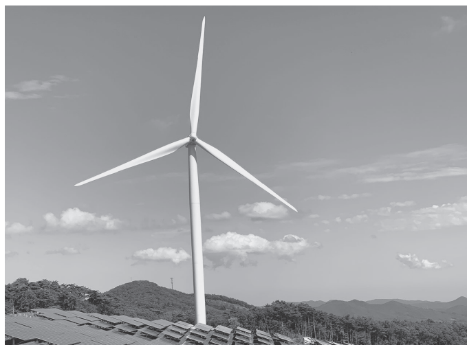
町に隣接する飯舘村に建てられた直径103メートルの巨大風車
