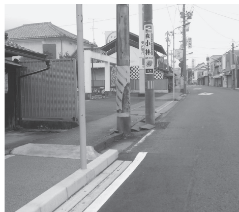
歩道整備途中の瓦町地内
