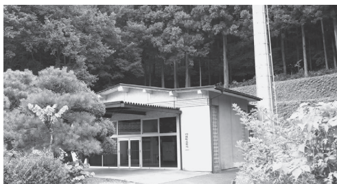
大規模改修に向け動き出した火葬場
