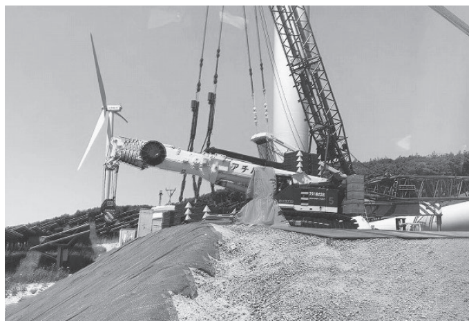
飯館村の風車建設現場
