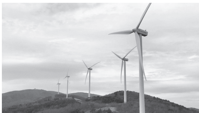
田村市滝根町の風力発電施設
