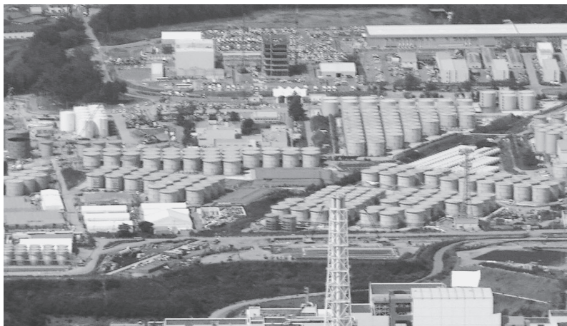
東京電力敷地内に置かれた汚染処理水タンク群
