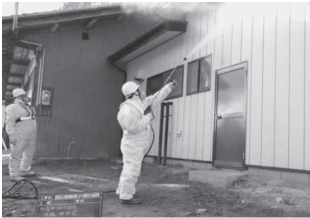
住宅除染のようす（山木屋坂下地区）
