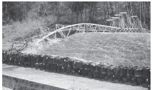
地震による地すべりで倒壊した外部電源用鉄塔
