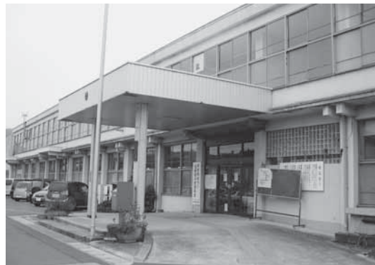
震災により利用不可能となった役場庁舎
