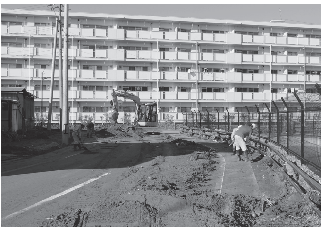
台風19号災害では建設事業者による懸命な復旧作業が行われました
