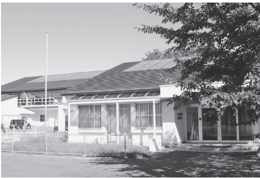
再開のため整備され、未活用の山木屋幼稚園
