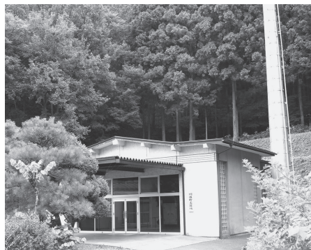
老朽化が進む火葬場
