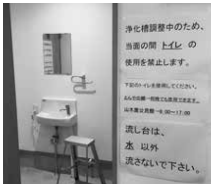
山木屋地区消防屯所のトイレ
