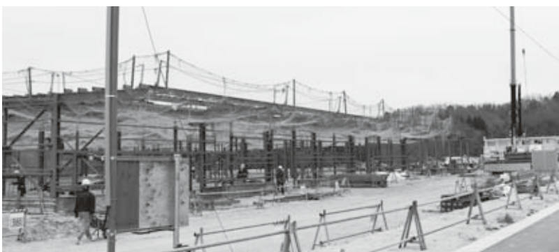
西部工業団地のミツフジ建設状況
