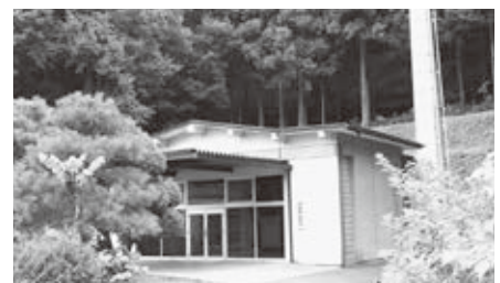
築44年が経過し老朽化した火葬場
