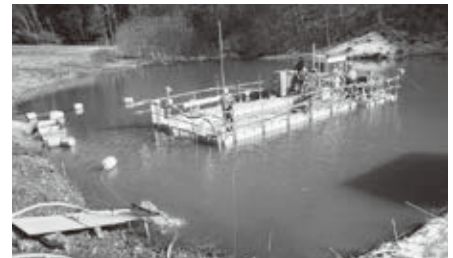
除染したため池（ポンプ吸引により浚渫除去する工法を採用）
