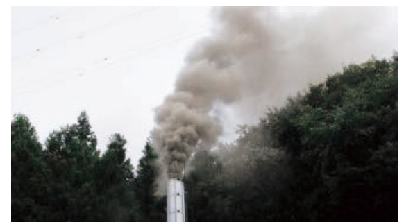
煙突から排出される黒煙
